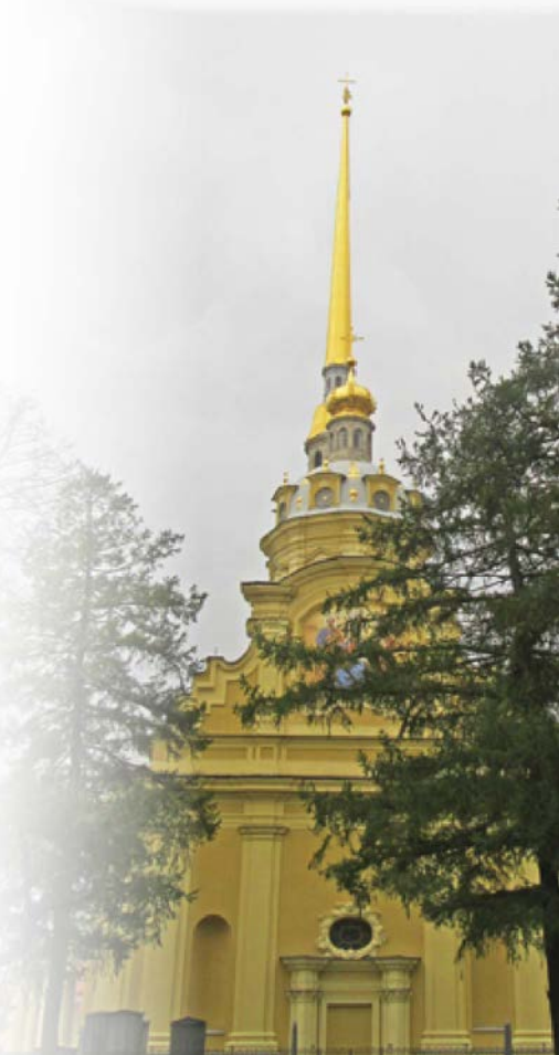
Колокольня Петропавловского собора
